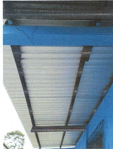
Foto 2: Techo del aula de computacion instalado.
