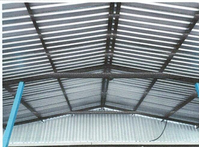
Foto1: Techo del escenario y corredor instalado.
