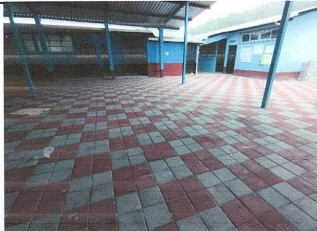
Foto 4: Piso del corredor y entrada intalado.
